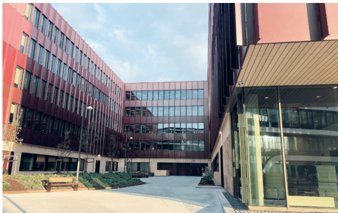
Gnist Vest består av fem fløyer, med parkeringsgarasje under deler av bygget.
